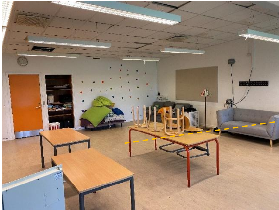
#31 Lokale 43. Prøve P9-P10 er udtaget fra støvfaser i lokalet.
