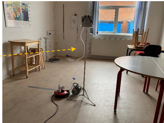
#56 Støvprøve P28-P29 og luftprøve MFAI8 er udtaget fra indeklimaet.
