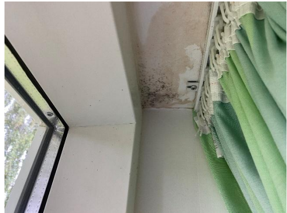
#28 Prøve P/T22 er udtaget fra misfarvninger på lysning.
