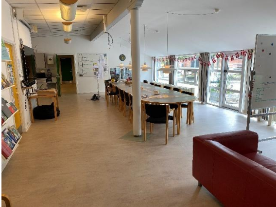
#43 Personalerum. Støvsprøve P13-P14 og luftprøve MFAI7 er udtaget fra lokalet.
