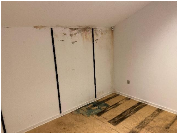
#47 Depot. Prøve P/T26 og P/T27 er udtaget fra hhv. væg og gulv.
