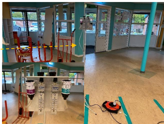
#74 Støvprøve P41-P43 og luftprøve MFAI16-MFAI17 er udtaget fra indeklimaet.
